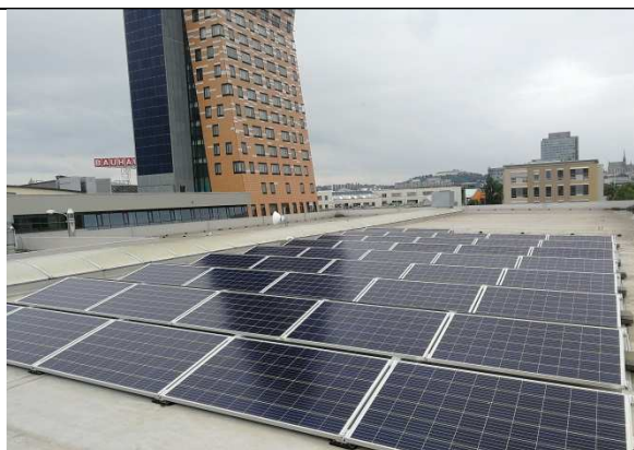
Fotovoltaické panely na střeše objektu
